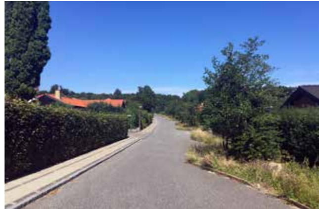
Karensvej i Skovkvarteret før og efter klimatilpasning: Vejen er koblet fra fælleskloakken og regnvandet ledes nu til regnbede med spredte træer og en beplantning, der har et naturligt udtryk. Ved skybrud ledes regnvandet videre til Aktivitetsskoven.
