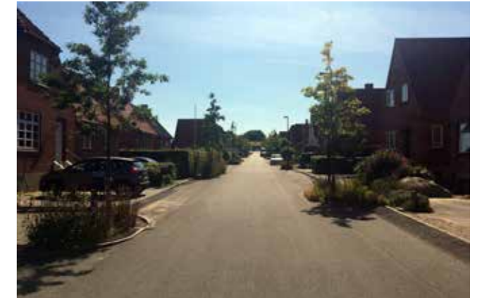
Egevej i Allékvarteret før og efter klimatilpasning: Fortovene i begge sider er fjernet for at give plads til regnbede, hvor der er plantet egetræer. Overløb fra regnbenedene i Allékvarteret ledes på overfladen ned over Vestre Kirkegård og er suppleret med en overløbsledning, så oversvømmelser på kirkegårdens arealer undgås.
